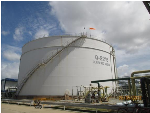
ภาพที่ 3.2-18 Clarified Water Tank (Q-2216)
