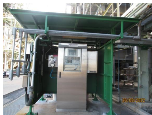
ภาพที่ 3.2-5 อุปกรณ์ตรวจวัดมลพิษอินฟราเรดแบบต่อเนื่อง (CEMs)
