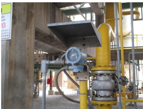
ภาพที่ 3.2-44 Flammable Gas Detector
