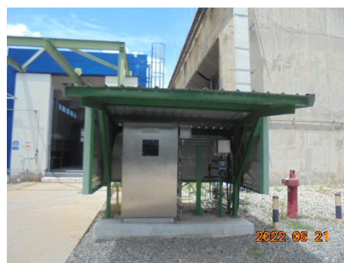
ภาพที่ 3.2-57 Conductivity Online ที่ Cooling Blowdown
