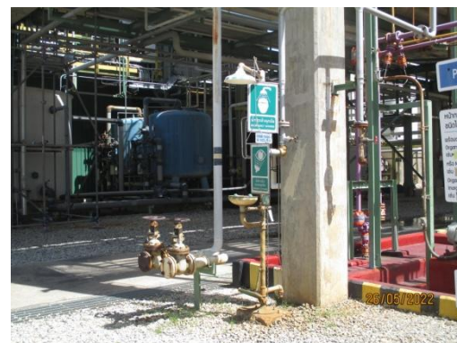
ภาพที่ 3.2-45 ฝักบัวฉุกเฉิน และที่ล้างตา
