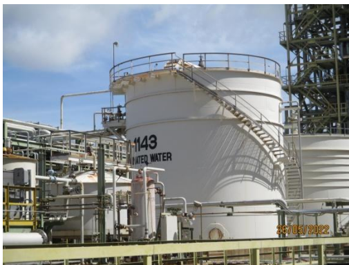
ภาพที่ 3.2-7 Contaminated Water Surge Tank (Q-1143)
